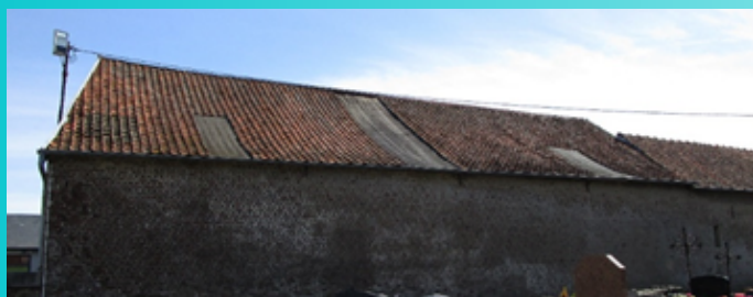
Bâtiment avant installation
